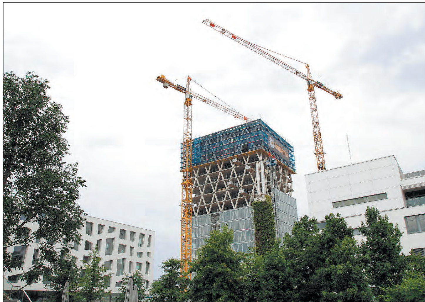
So wie das Roche-Hochhaus in Rotkreuz in die Höhe wächst, so stieg in den vergangenen Jahren auch die Zahl der Arbeitsplätze und der Einwohner im Kanton Zug.
