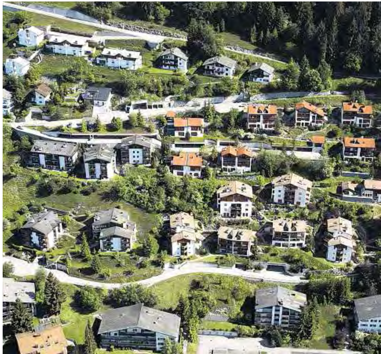
Geregelt: Viele Kantone, hier ein Feriendorf bei Flims, kennen Regeln zum Zweitwohnungsbau.
