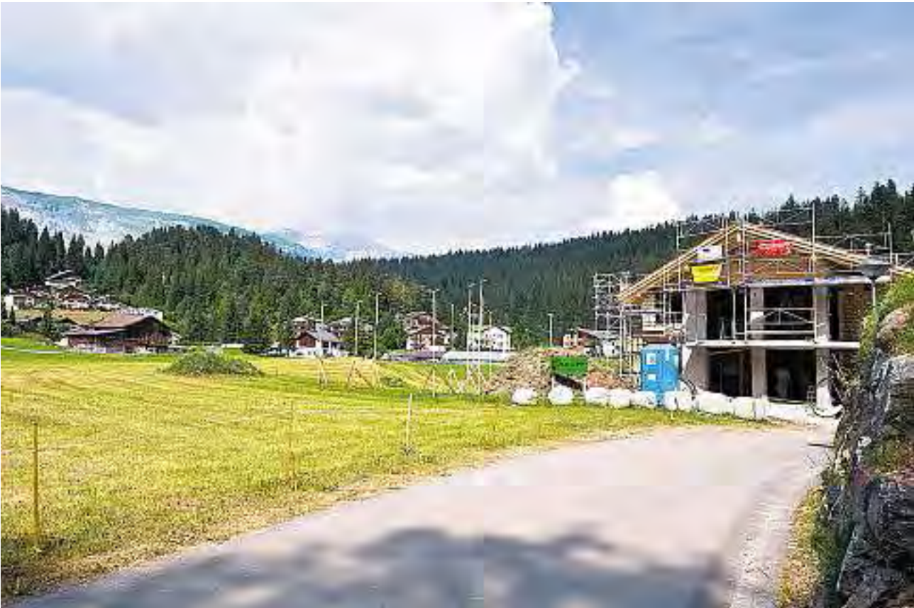
Baustellen überall im Ort: In Laax werden derzeit trotz – oder wegen – einer Planungszone mit temporärer Kontingentierung gleich 60 Zweitwohnungen gebaut. Bild Marco Hartmann
